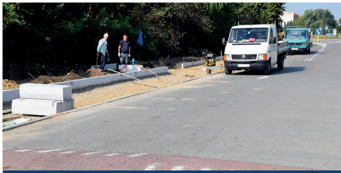
Budowa chodnika przy ul. Modrzewskiego
