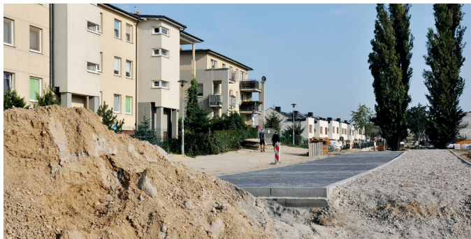
Budowa układu drogowego ul. Olszewskiego
