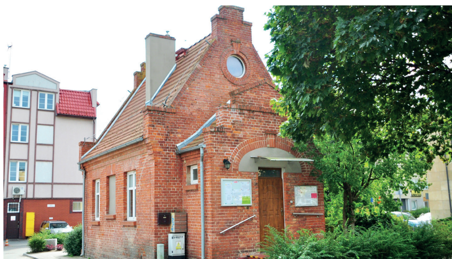
Budynek przy ul. Kossaka 13
