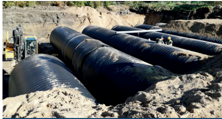
Budowa zbiornika retencyjnego
