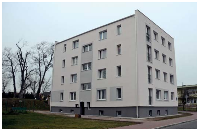
Nowa elewacja budynku przy ul. Ogrodowej 1
