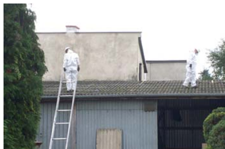
Demontaż eternitu z dachu
