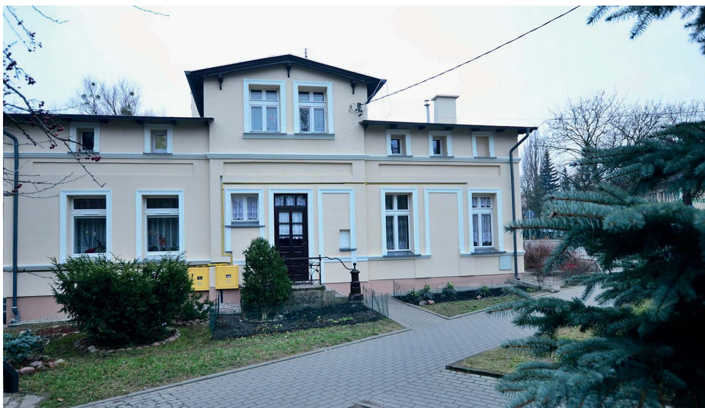
Nowa elewacja budynku przy ul. Wojska Polskiego 1
