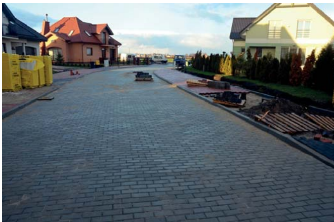
Koniec prac przy ul. Mazepy
