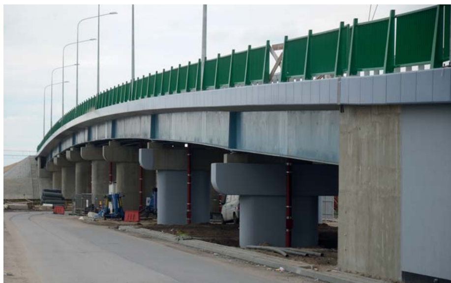
Nowy wiadukt nad torami
