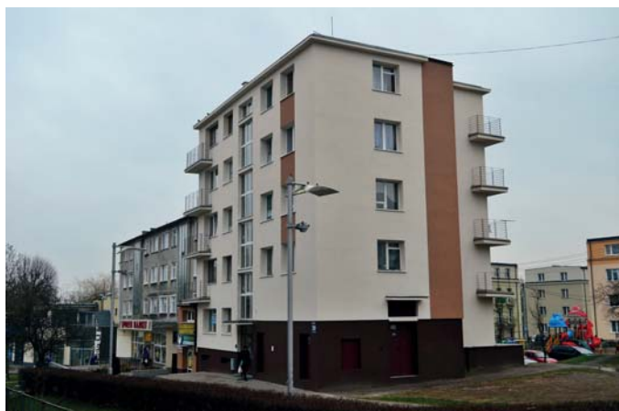
Nowa elewacja budynku przy ul. Wojska Polskiego 20
