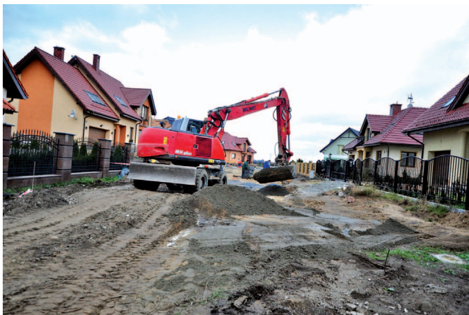
Budowa ul. Mazepy
