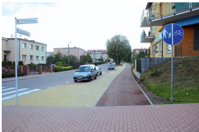
Nowy chodnik i ścieżka rowerowa przy ul. Mickiewicza
